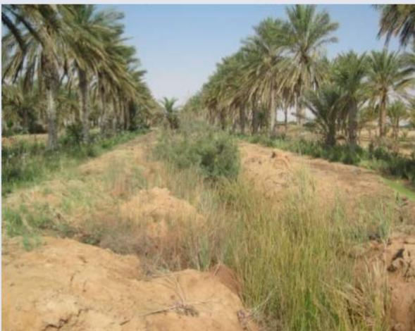
Figure 32. Canal collecteur secondaire colmaté par les roseaux.
