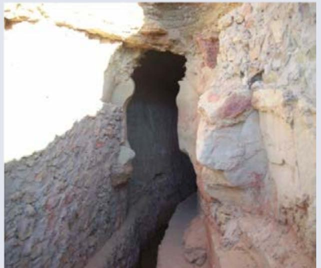
Figure 10. Partiteur d'une foggara à l'entrée d'une oasis.
