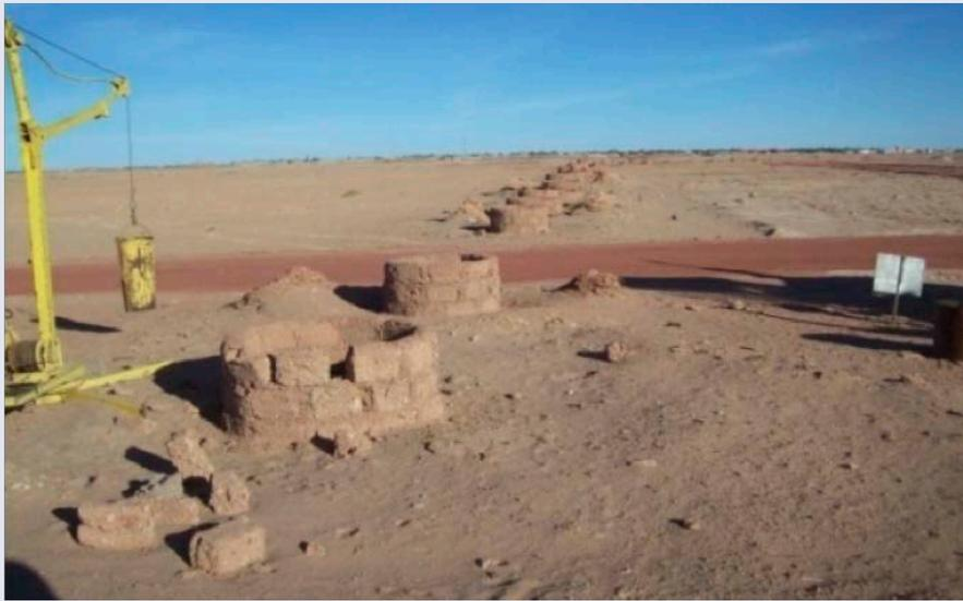
Figure 7. Vue au sol des bouches des puits verticaux de la foggara de Tamentit en cours de réhabilitation sur la route Adrar-Reggane.
