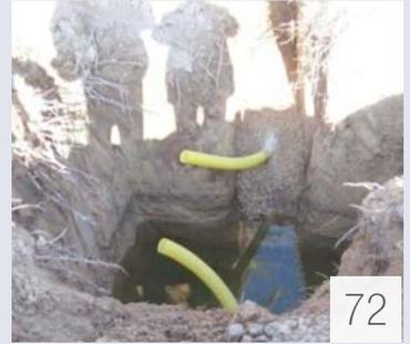
Figure 70. Creusage des tranchées des drains.
