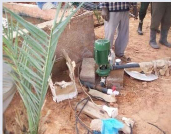
Figure 18. Installation d'une électropompe refoulante à la sortie d'un bassin de stockage pour la mise sous pression du réseau d'irrigation localisé.
