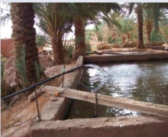
Figure 17. Raccordement d'un puits à un bassin individuel de stockage pour la mise sous pression du nouveau réseau d'irrigation localisée.
